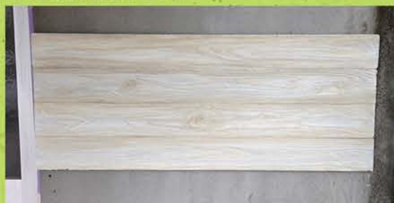
浮造を既設壁に再現
