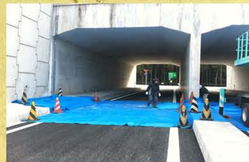
土木工事にも
