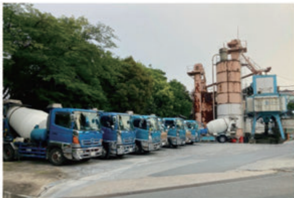
資料1 ■ 小島建材店の本社。同社は2022年1月7日から2月3日にかけて、戻りコンを不正に再利用していた（写真：日経クロステック）
