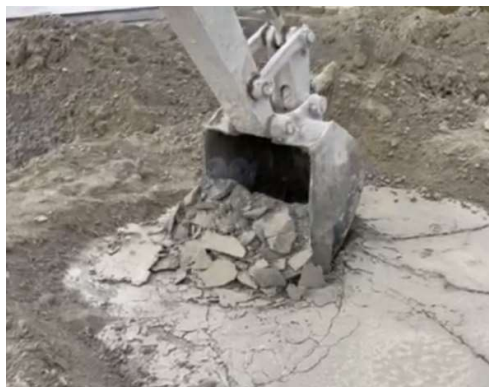
④28日経過後 掘削状況
