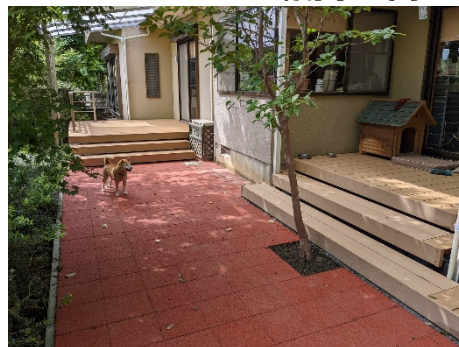
② 仕上がり
